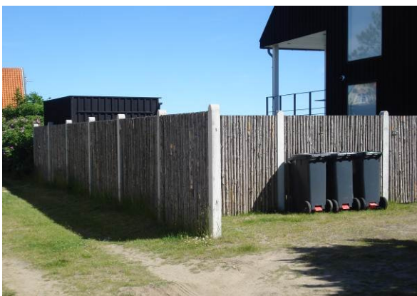
Liselejehegn – hegnstype 1 – kan også nyetableres, hvilket dette kun få år gamle hegn er et godt eksempel på. Opført helt efter de klassiske Liselejehegns-dyder er hegnet med til at fastholde noget af Liselejes karakter, selv om selve byggeriet er helt moderne. Eksemplet viser, at hegnene er et vigtigt karakterskabende element i Liseleje.
