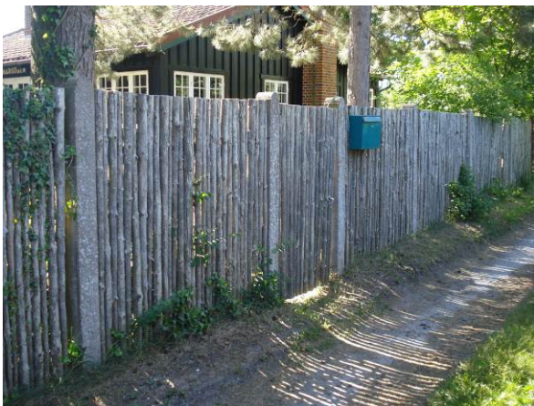
Hegn af samme type men noget højere og med ubehandlede rafter. Stolperne har afrundet top med en lille affasning i bunden af buen. Låge udført som hegnet.
